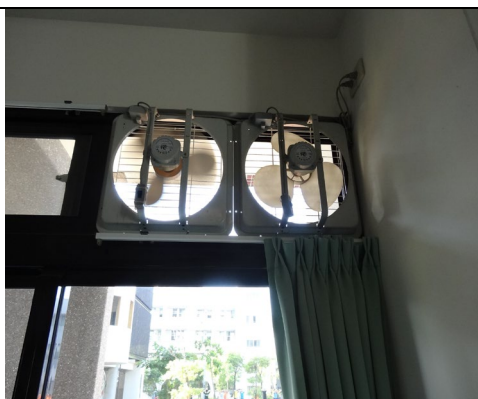
透過散熱排風扇，透過對流降低高溫
