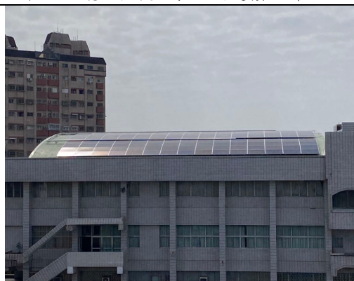
校舍屋頂裝設太陽能板隔熱與遮陽設計
